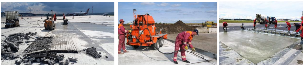
Rasm 6.54. Sementbeton qoplamasini joriy ta'mirlash texnologik jarayonlari
