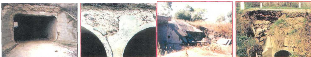
Rasm 6.14. Qirg‘oq va suv o‘tkazgich kallagi qiyaliklarini mustahkamlash
