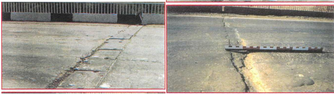
Rasm 6.12. Kengayish bo‘g‘imlari bo‘ylab yulka qatlamlarini lokal ravishda yo‘q qilish, mastik chipslari
