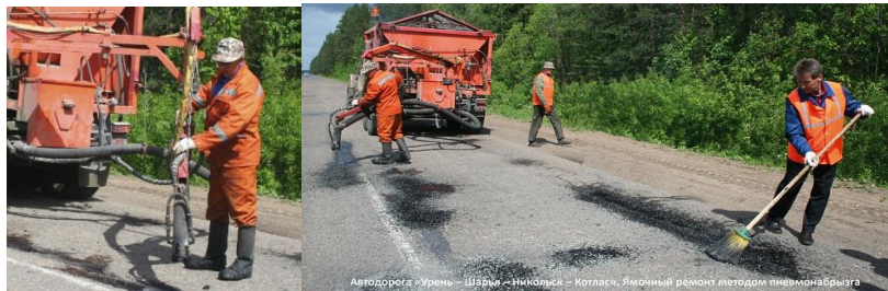
Rasm 6.42. Sovuq in'ektsiya teshiklarini muhrlash texnologiyasi
