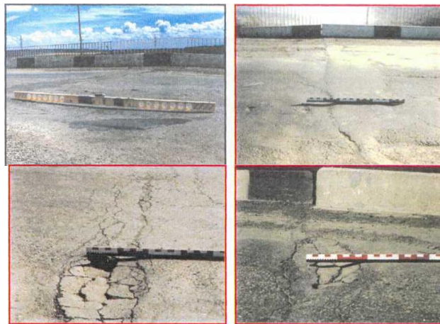
Rasm 6.13. Ko‘priknining ko‘milish bilan kesishgan qismida kesishmalar mavjudligi
