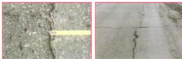
Rasm 6.2. Qoplamada ishlov berilmagan yoriqlarning ko‘rinishi.
