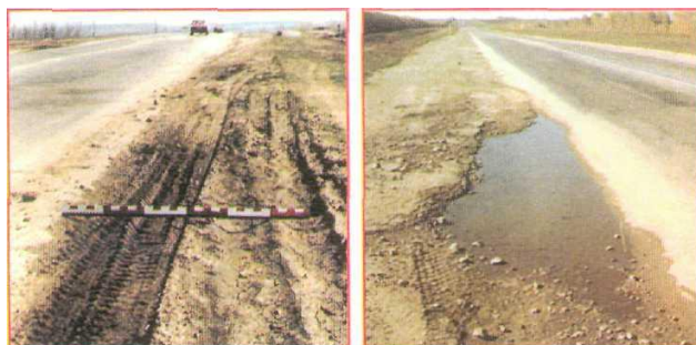
Rasm 6.9. Yon tomonlarda va ajratuvchi chiziqdagi suvning shikastlanishi, pasayishi va turg'unlikning mavjudligi
