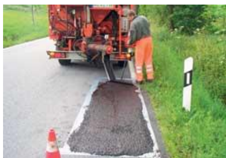
Rasm 6.37. Yopiq in'ektsiyasini ta'mirlash texnologiyasi
