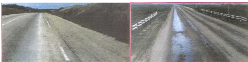
Rasm 6.1. Qoplamaning chekkasida va bitumni terlash uchun ishlov berilmagan joylarda ifloslanish chiziqlar mavjudligi
