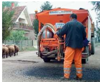
Rasm 6.37. Yopiq in'ektsiyasini ta'mirlash texnologiyasi
