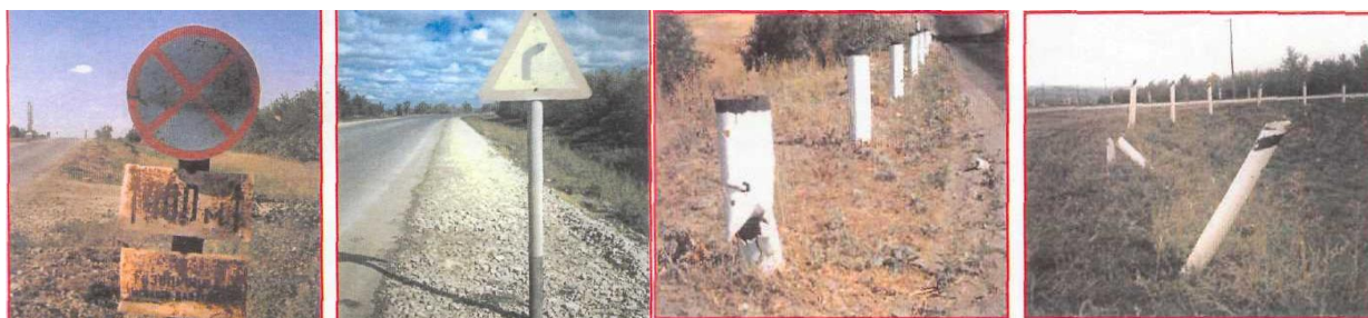
Rasm 6.15. Amaldagi standartlar, me'yorlar va qoidalarni buzgan holda harakatni tashkil qilish uchun texnik vositalarni o'rnatish
