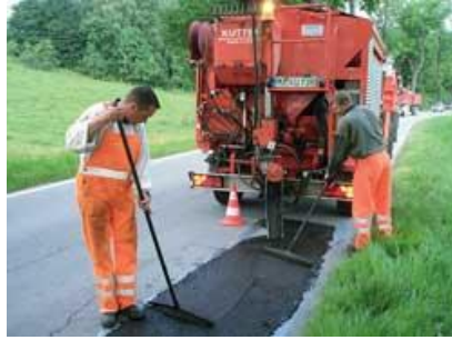
Rasm 6.38. Yupqa qatlamli sovuq yotqizish texnologiyasi (Microsurfacing) ish tugagandan 30 minut o‘tgach yo‘lni ochishga imkon beradi
